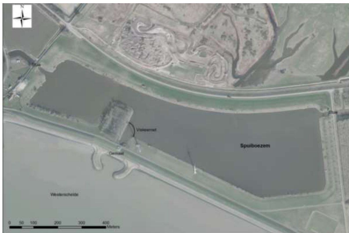
Figuur 1.1 Luchtfoto Spuiboezem te Bath.
